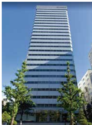
札幌センタービル
